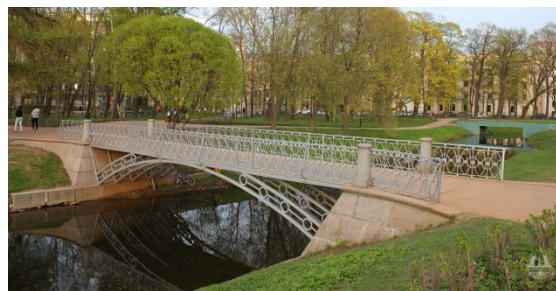
Рисунок 5. Мост №4 в Таврическом саду (Санкт-Петербург)
